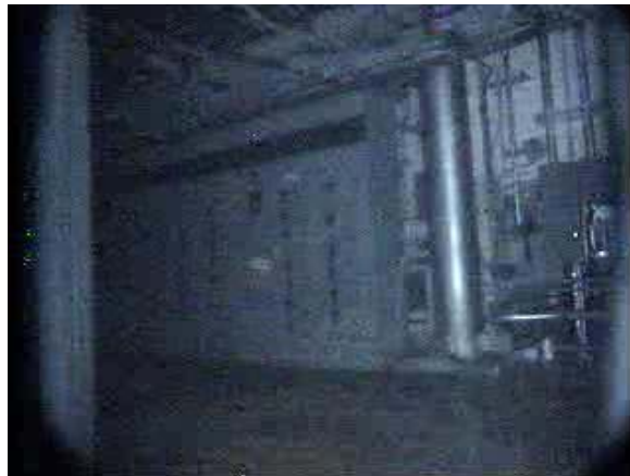
2号機原子炉建屋1階
