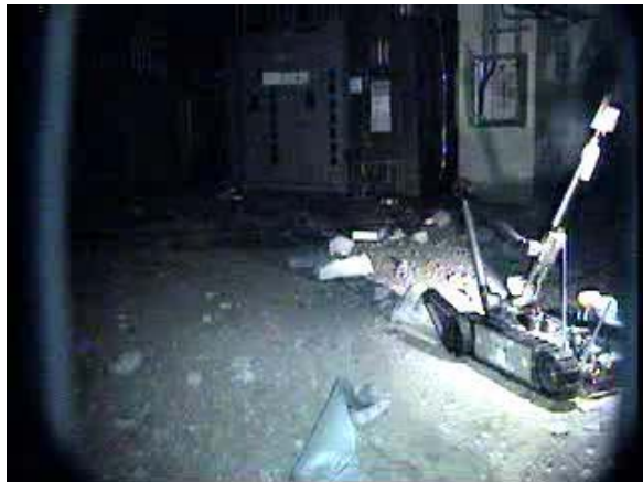
1号機原子炉建屋1階
