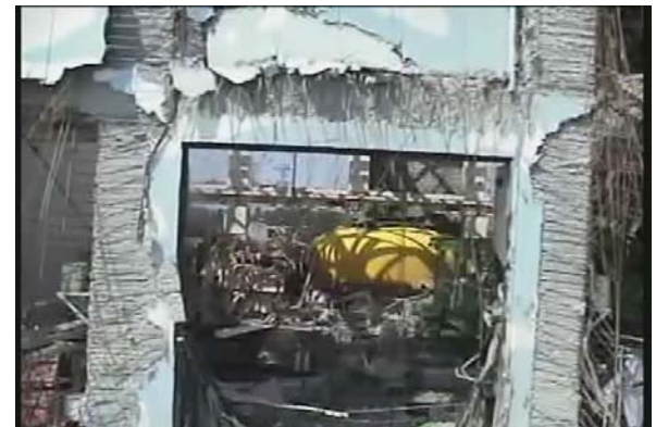
4号機東側より建屋内部
