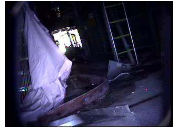
3号機原子炉建屋1階
