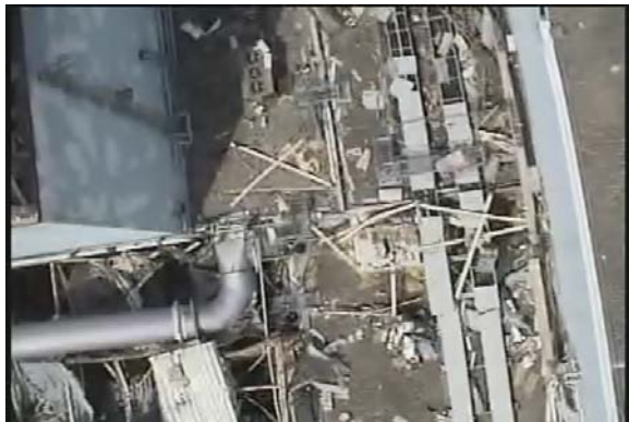
1号機南東角建屋カバー柱
