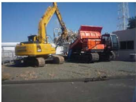
仮置き場設置作業
