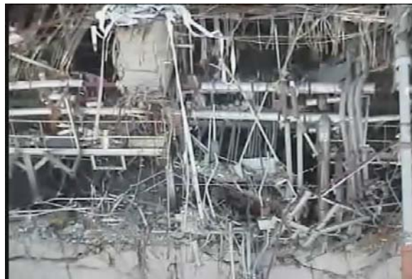
3号機西側より建屋内部
