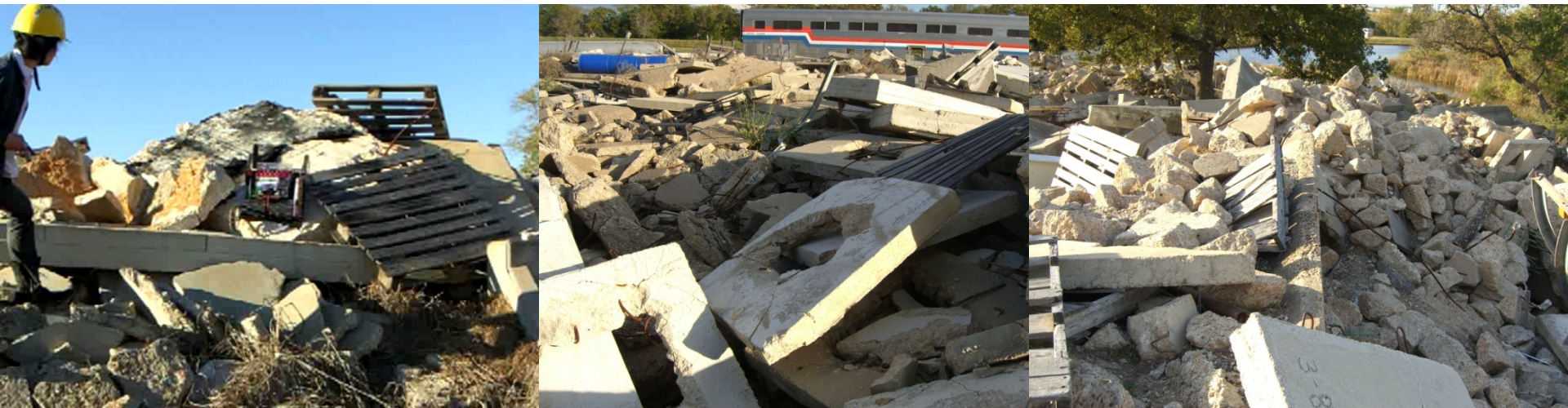
コンクリート瓦礫(約40m四方)を端から端まで踏破
