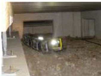
IRS 蒼龍による床下点検
